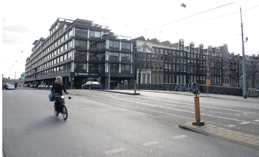
Gebouw 'Duintjer' in de Vijzelstraat.
