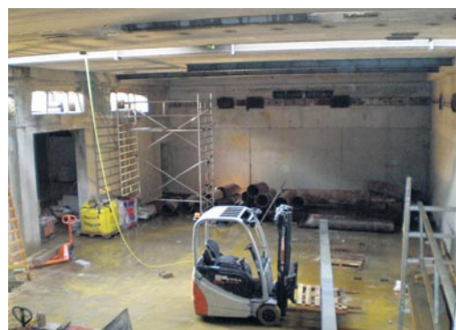
De ondergrondse gymzaal in aanbouw.
